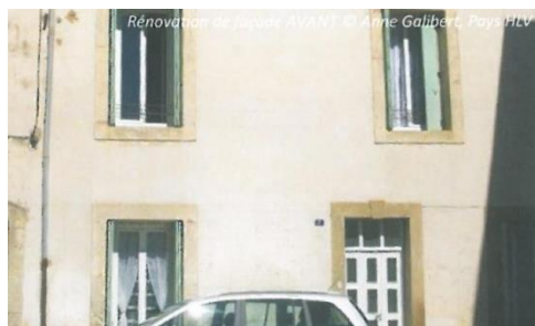
Rénovation de façade AVANT © Anne Galibert, Pays HLV
