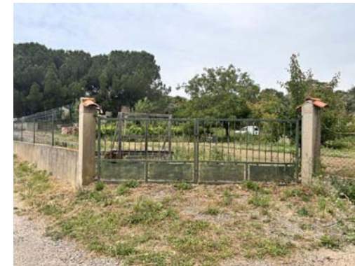
Photo n°6 : Entrée de la parcelle n°1093
