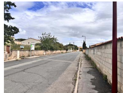
Photo n°1 : Chemin des Baraques
